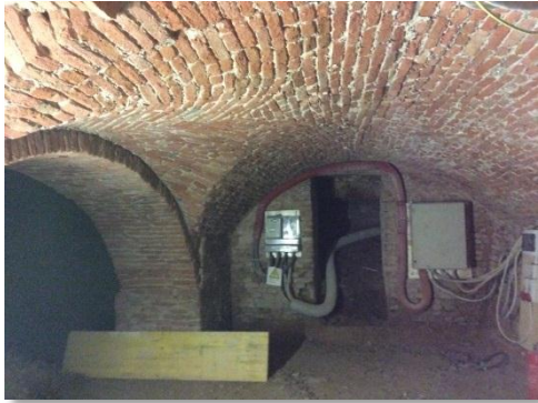
Locali sotterranei Volte
