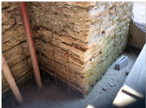
Locali sotterranei Umidità
