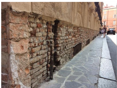
Esterno Scalcinatura zoccolo
