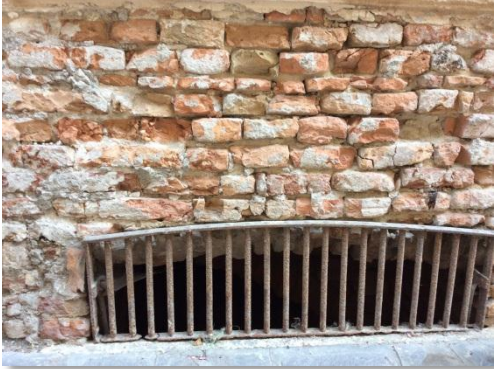
Esterno Particolare bocca di lupo
