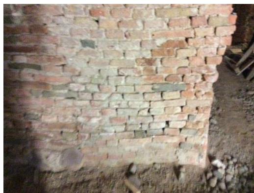
Locali sotterranei Stato della muratura
