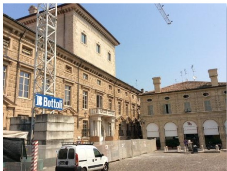
Prospetto principale. Lavori di restauro in corso
