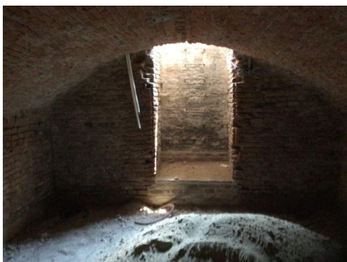
Locali sotterranei Bocca di lupo
