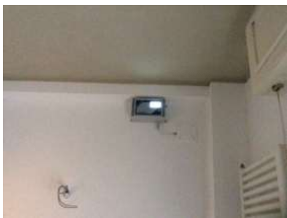
Interno Installazione Tergomatic
