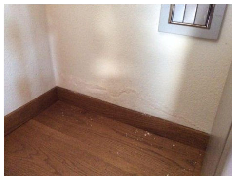
Umidità sfarinamento strato pittorico
