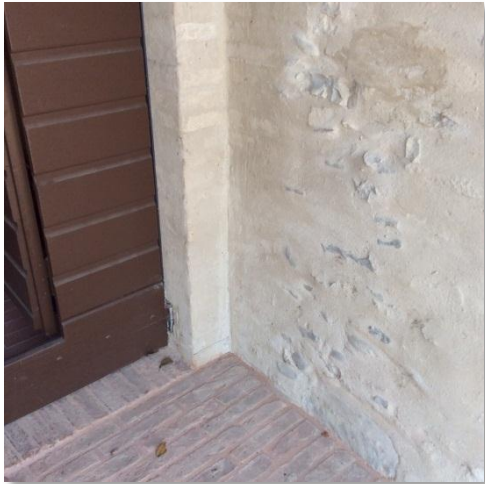
Esterno Degrado intonaco
