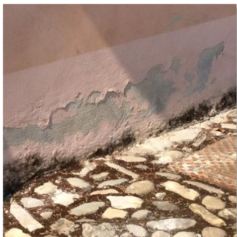
Esterno Degrado intonaco
