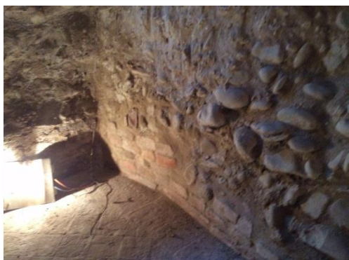
Locale interrato Muratura a vista con umidità
